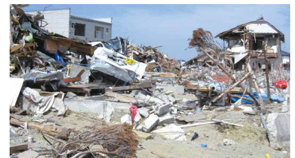
Zona de viviendas destruidas
