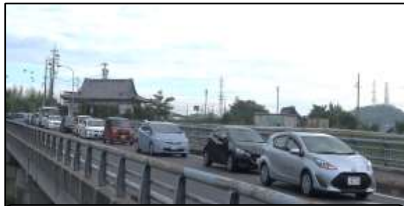
【現道】渋滞発生箇所【貝家橋南詰交差点】
