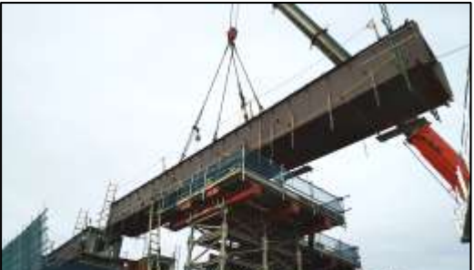
采女大橋架設
