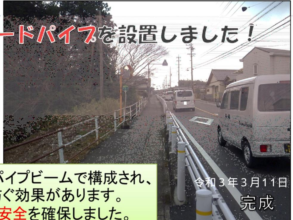
ガードパイプは支柱とパイプビームで構成され、歩道への車の侵入を防ぐ効果があります。設置によって通学路の安全を確保しました。
