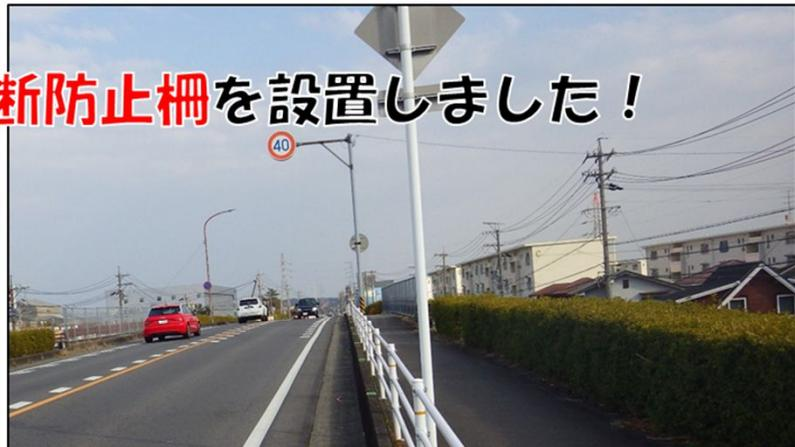
横断防止柵は支柱とパイプビームで構成され、風にあおられた歩行者が車道へ飛び出すのを防ぎます。設置によって通学路の安全を確保しました。
