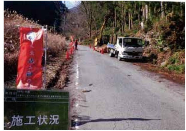
事前伐採の施工中の状況（松阪市）
