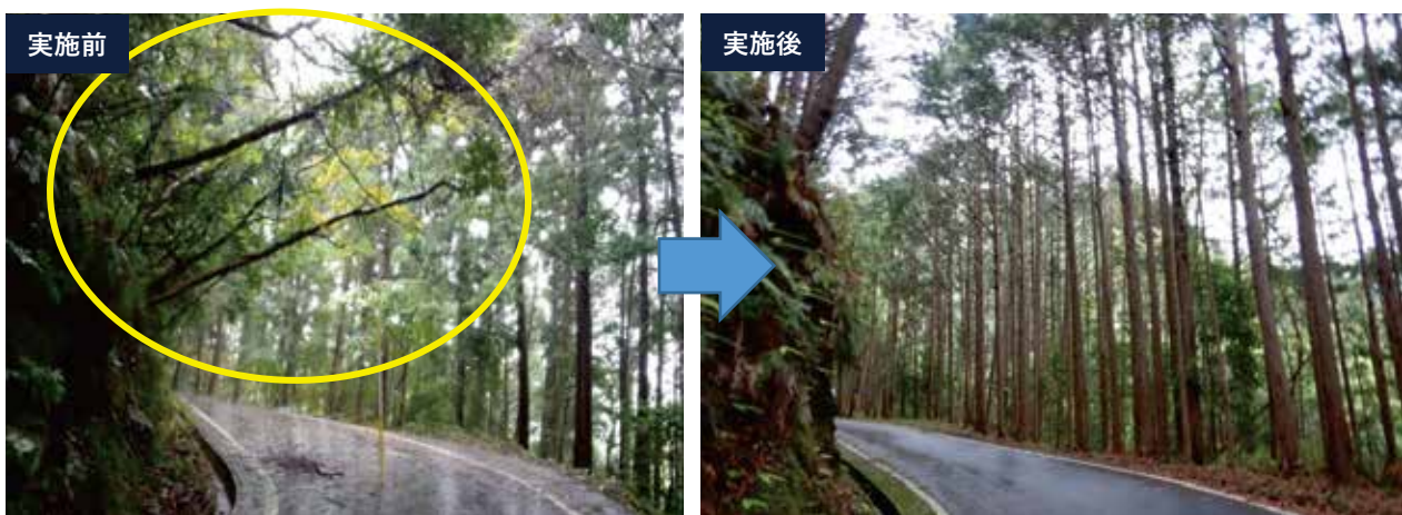
暮らしを守る危険木伐採事業 生活道路に倒れかかっている危険木を除去した様子
