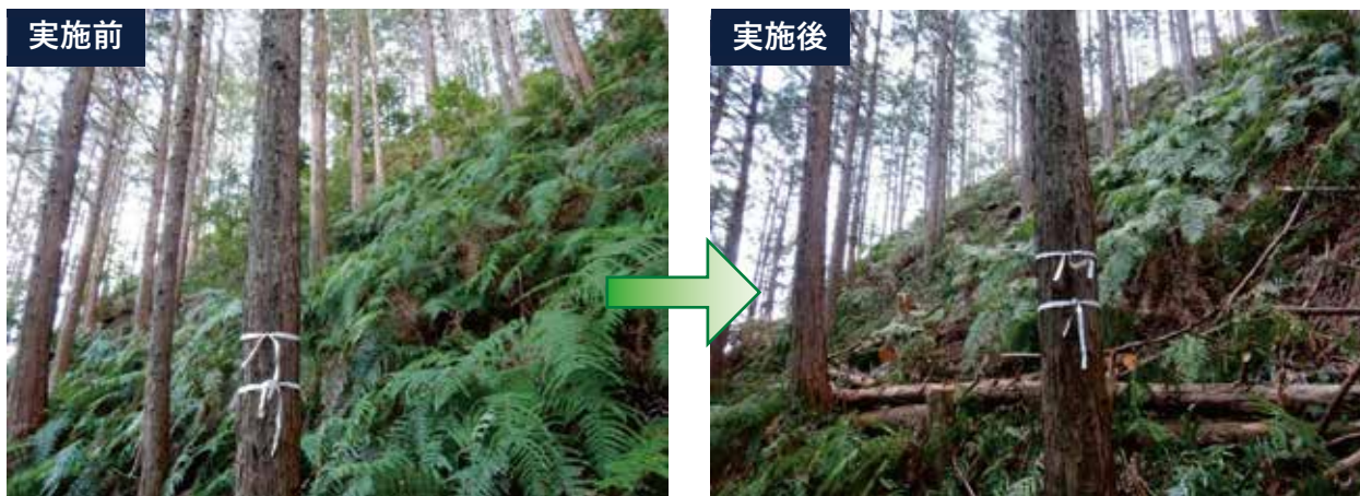
根系や下層植生の発達を促す森林整備の施工状況（熊野市）
