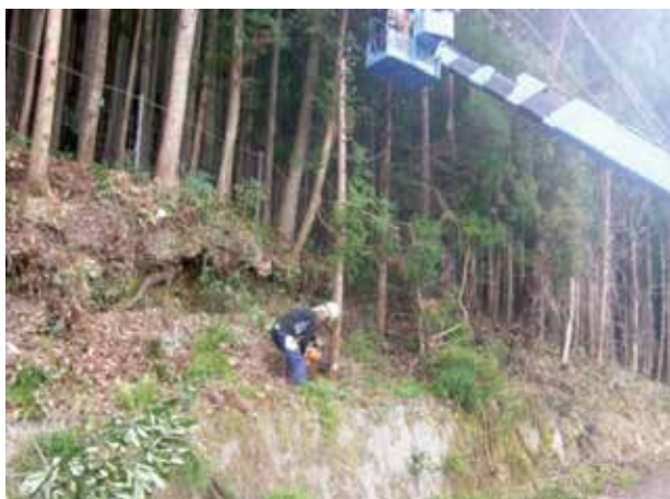
集落周辺等危険木伐採事業 危険木を伐採している様子
