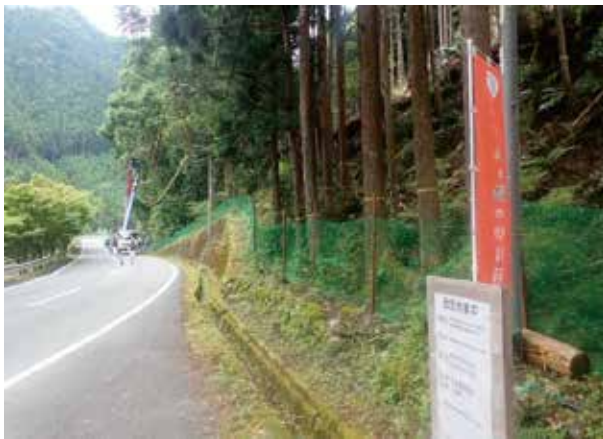
事前伐採の施工中の状況（大台町）
