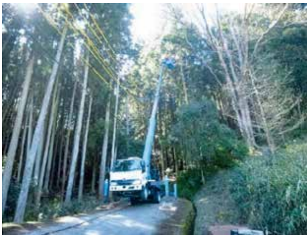
災害からライフラインを守る事前伐採事業 台風等で電線を寸断する恐れのある樹木を 高所作業車を使って伐採している様子
