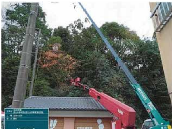
里山の森林安全安心対策事業 クレーン車と高所作業車を使って 公共施設周辺の危険木を除去している様子
