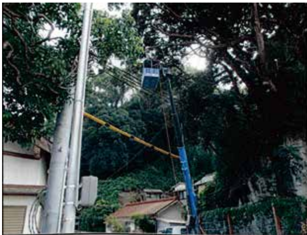
生活環境林整備事業 中学校入口付近の危険木を 高所作業車を使って除去している様子
