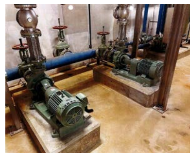
設備の整備、更新（ろ過原水ポンプ）
