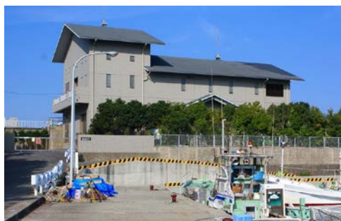
漁業集落排水処理施設
