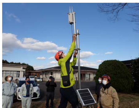
LPWAN 中継機の設置
