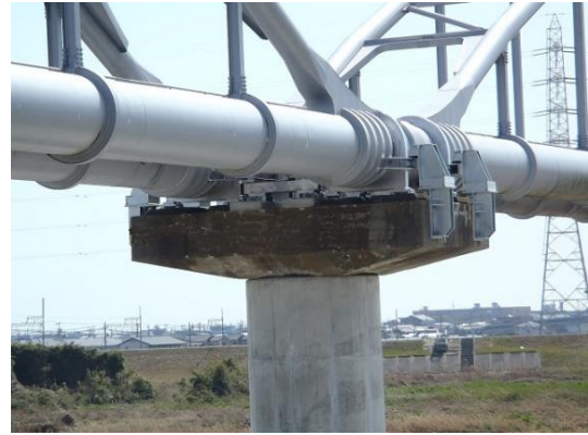
鈴鹿川第 2 水管橋の耐震化
