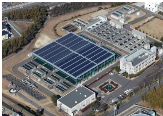
太陽光発電設備（播磨浄水場）
