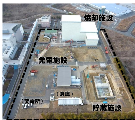
現況 (令和4年2月)
