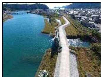
堤防強化事業(船津川) 【三重県】
