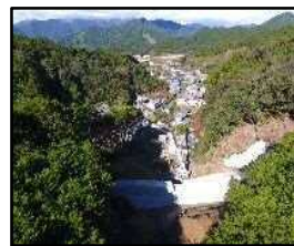
砂防堰堤の整備(猿谷) 【三重県】
