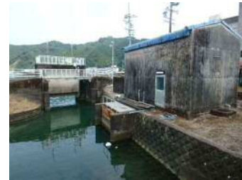
汐ノ津呂排水機場(排水ポンプ増設) 【紀北町】
