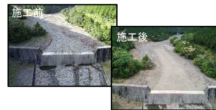
砂防堆積土砂撤去事業(大野内川) 【三重県】
