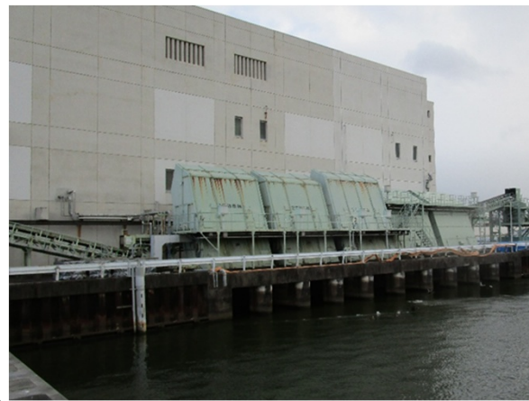
ポンプ場整備
