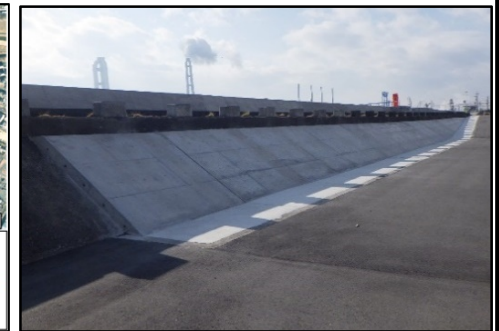
川越地区海岸における堤防整備 (三重県)
