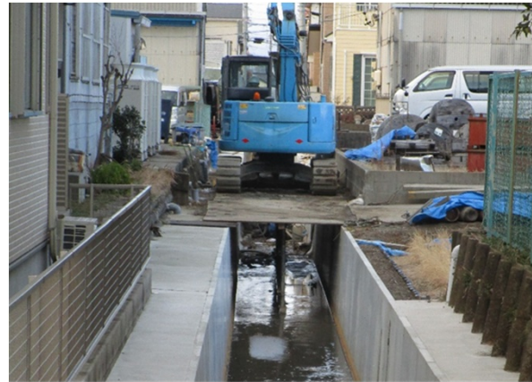
下水道（雨水排水）施設の整備
