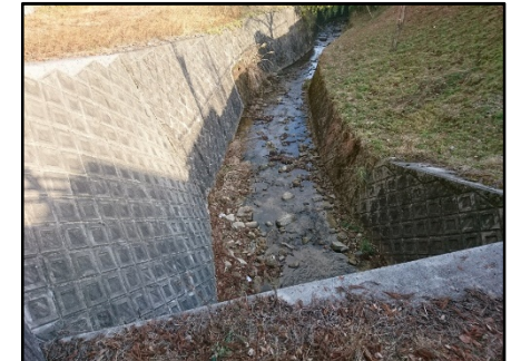
雲田川における浚渫 (菰野町)
