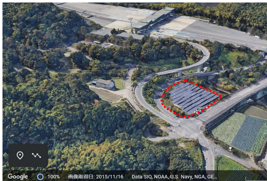
関西空港自動車道上之郷インター（大阪府）
