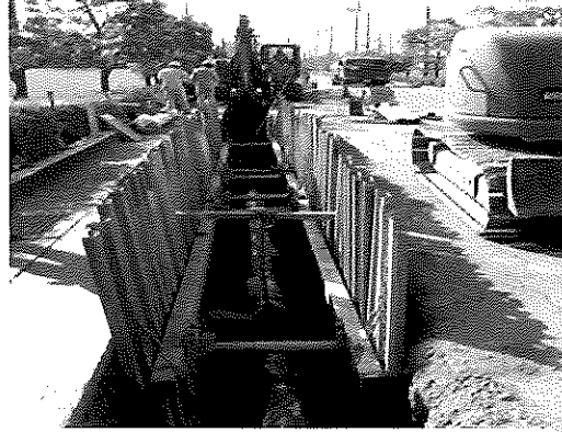
管路布設替えの状況
