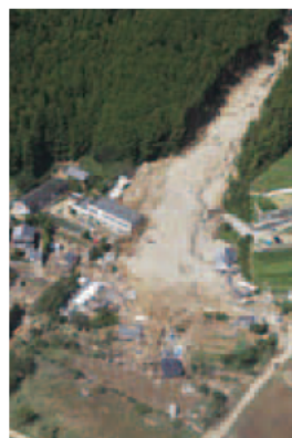
紀伊半島大水害の被害
