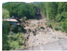
旧宮川村の被害(平成16年)
