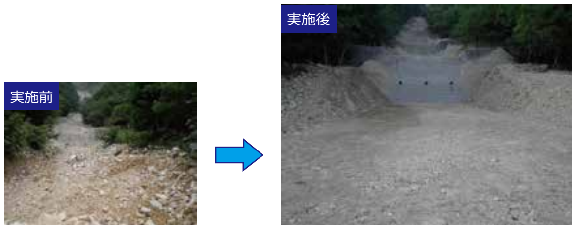
写真 土砂・流木緊急除去事業実施状況 松阪市（大崩）
