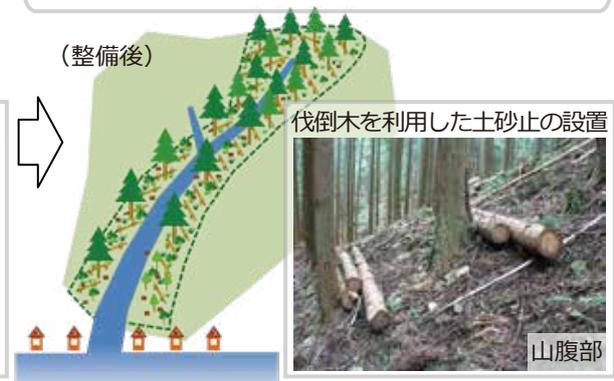
伐倒木を利用した土砂止の設置
