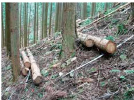
写真 伐倒木を利用した土砂止め
