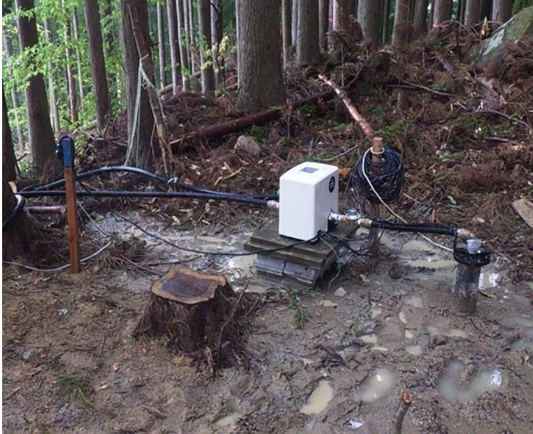
(地下水排除工)
