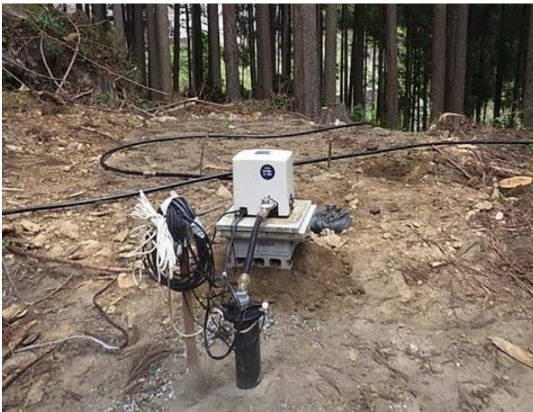
(地下水排除工)
