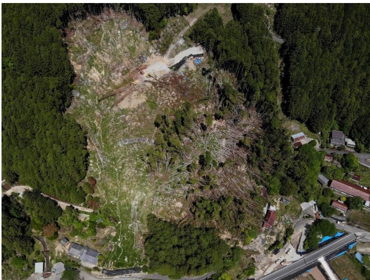
(施工後緑化状況)
