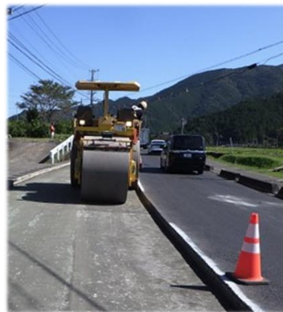
舗装の打ち換え
