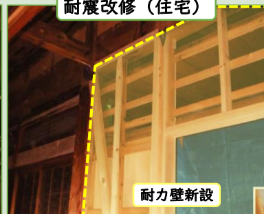
耐震改修 (住宅)
