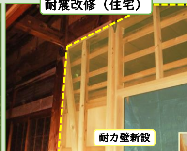
耐震改修 (住宅)
