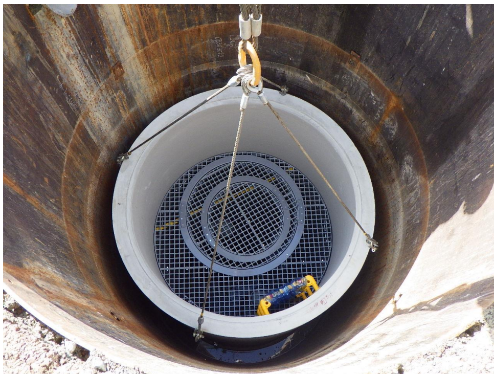
<人孔工（マンホール設置状況）>
