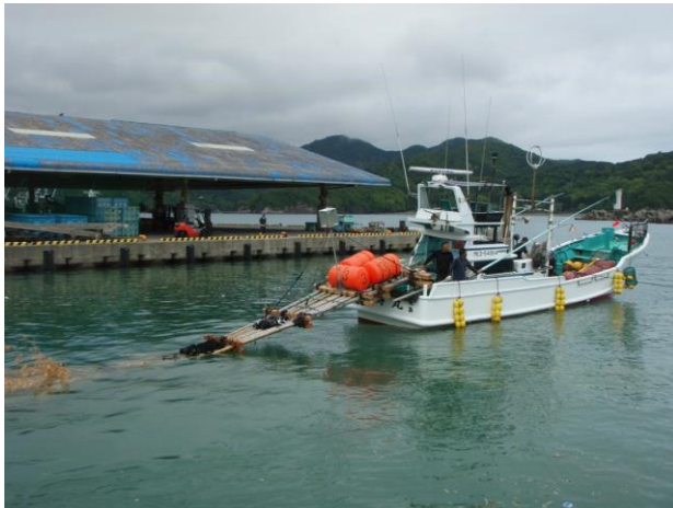
写真 設置に向けた浮体運搬
