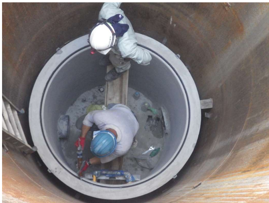
<人孔工（マンホール設置状況）>
