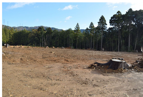
写真4 埋め戻し後（西から）
