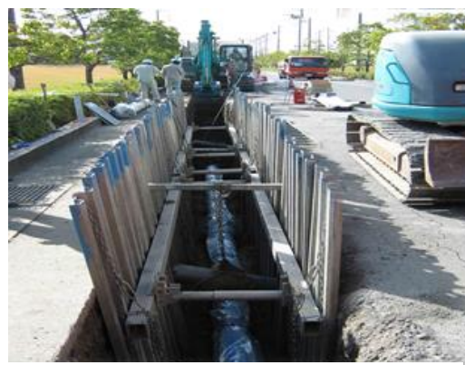
管路布設替えの状況
