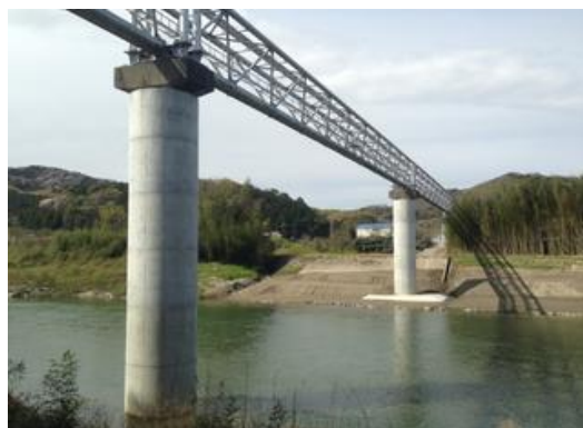
櫛田川水管橋下部工の耐震化
