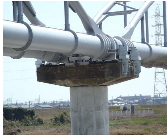
鈴鹿川第2水管橋の耐震化
