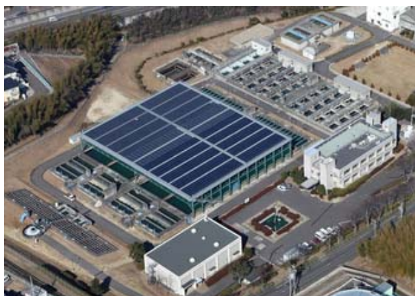
太陽光発電設備（播磨浄水場）
