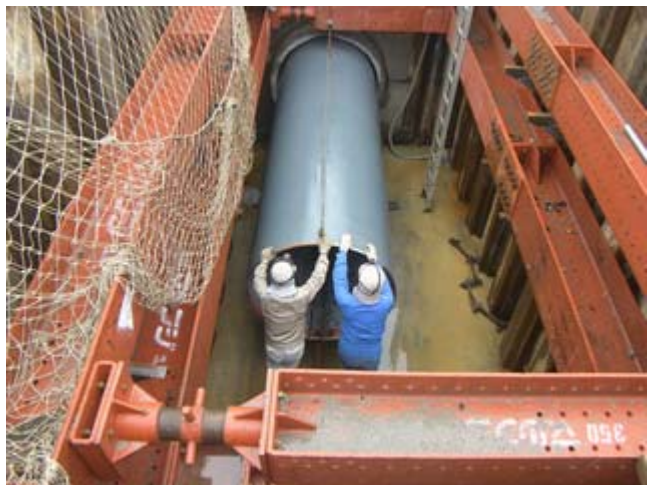
パイプインパイプ工法による管更生工事
