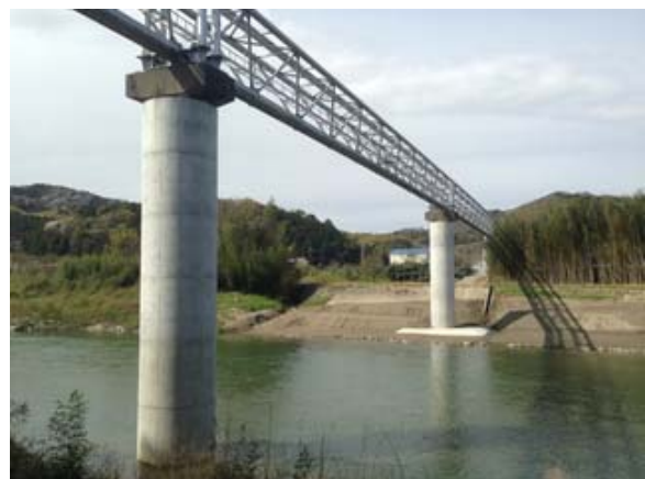
櫛田川水管橋下部工の耐震化
