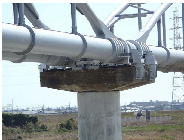
鈴鹿川第2水管橋の耐震化
