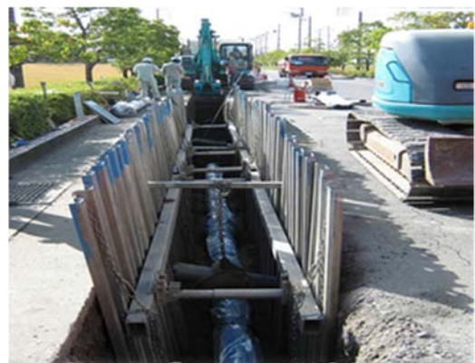
管路布設替えの状況
