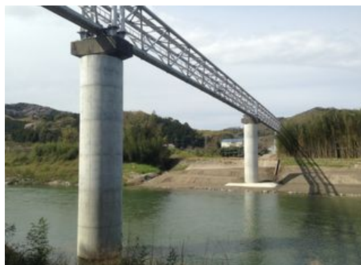
櫛田川水管橋下部工の耐震化
