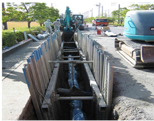
管路布設替えの状況
