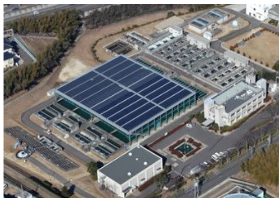
太陽光発電設備（播磨浄水場）
