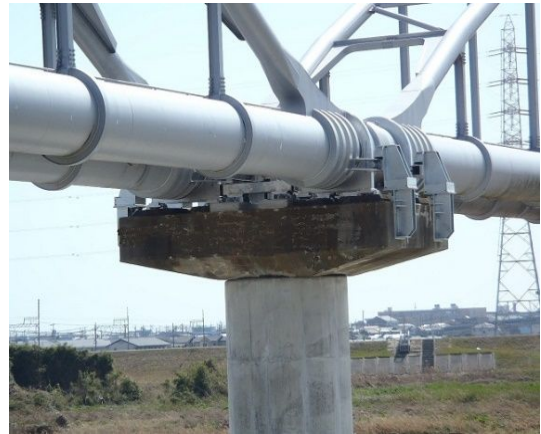
鈴鹿川第 2 水管橋の耐震化
