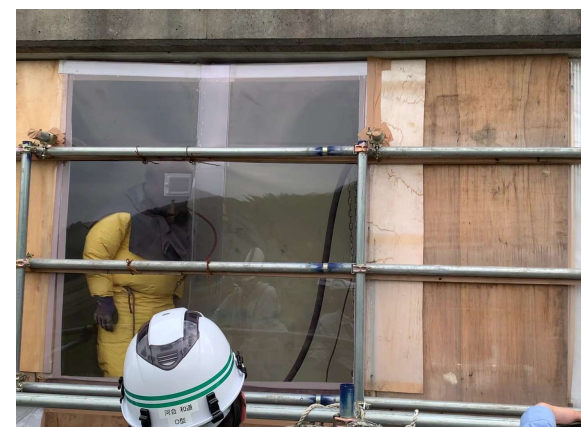
塗膜除去作業の見学
