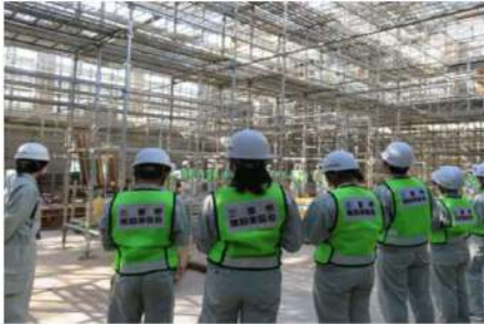
小学校屋内運動場 建築現場見学
