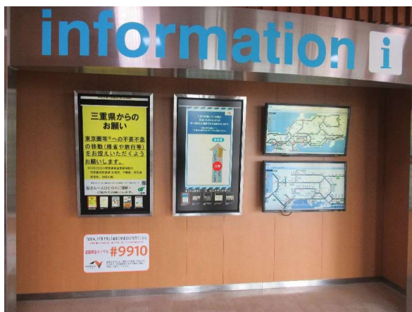
※ 高速道路SA・PAにおける設置状況
