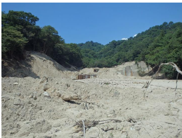
図. 5 工事着手前写真（下流側より望む）
