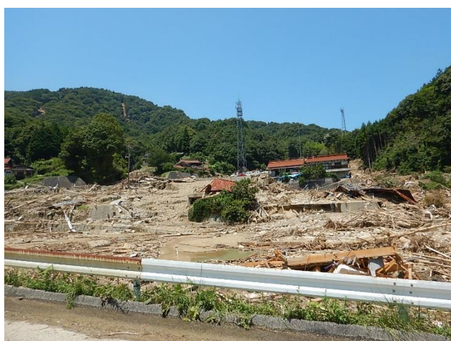
図.2 呉市安浦町市原地区の被災状況(2)
