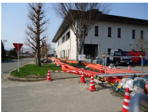
地上に設置された仮設配管
