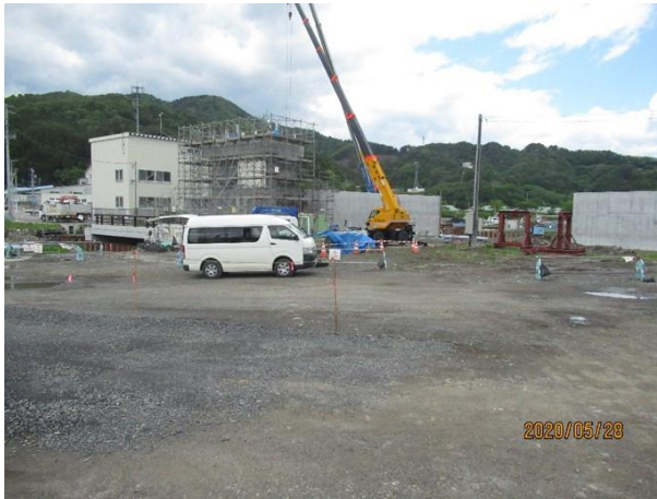
水道施設災害復旧事業工事状況
