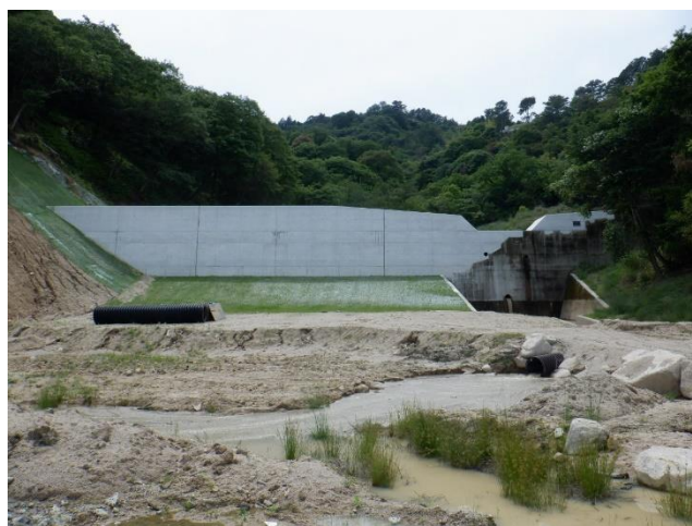
図. 6 工事完成写真（下流側より望む）
