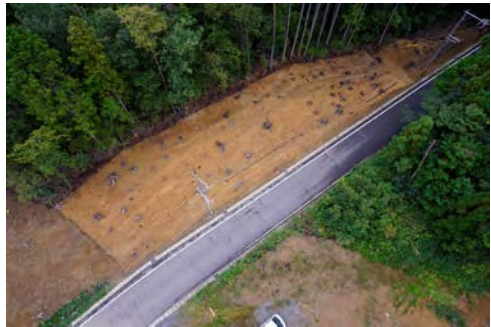
調査区南部全景 (北西から)
