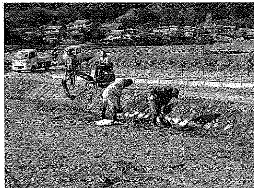
法面の修復作業風景
