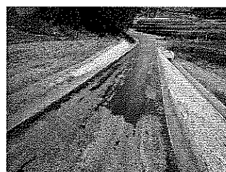
農道2号 完成 (河内広石原線・前田河内広線)
