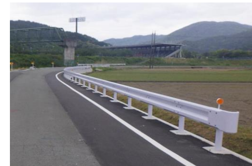
ガードレール
