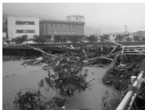
県内に甚大な被害をもたらした紀伊半島大水害（平成23年9月）
