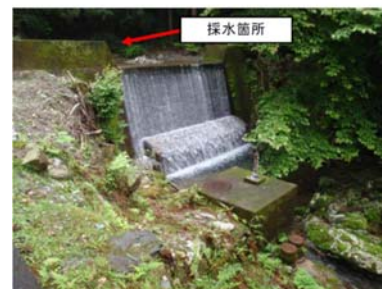
注連指浄水場取水口上流
