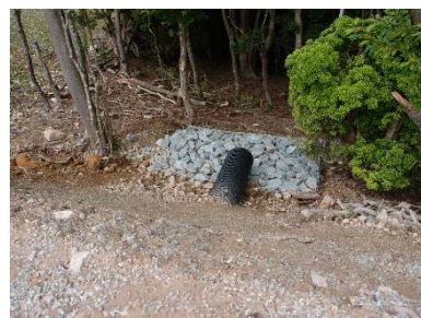
沈砂マスの設置状況 平成 28 年 6 月
