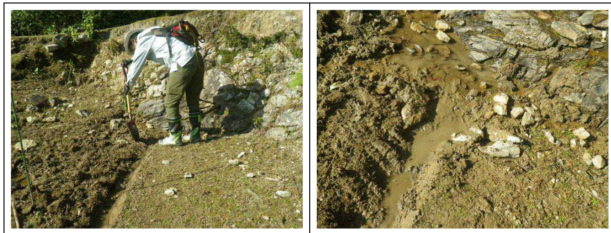
図 2.3.5 維持管理作業状況
