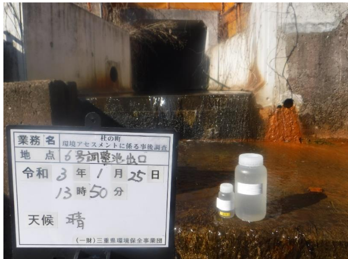
写真 2-1-17 濁水採水状況 (No.6) 令和 3 年 1 月 25 日
