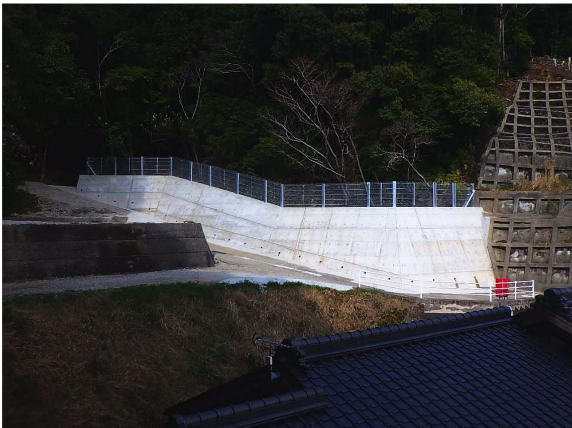
重力式擁壁工  $H=3.5\text{m}\sim 5.2\text{m}$
