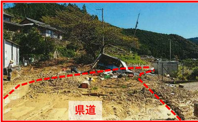
被災写真（県道が崩土により通行止め）
