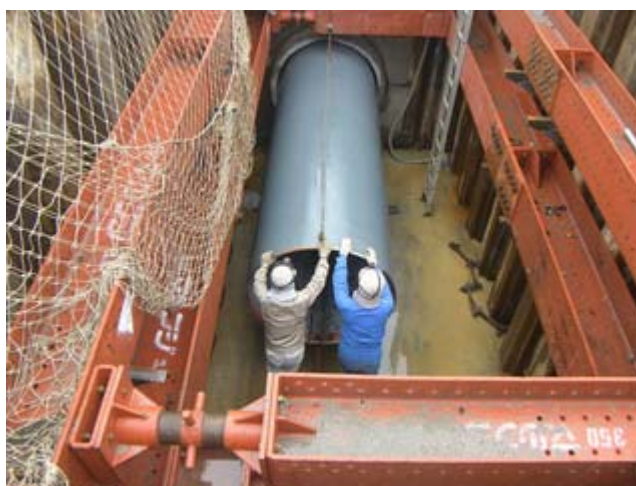
パイプインパイプ工法による管更生工事
