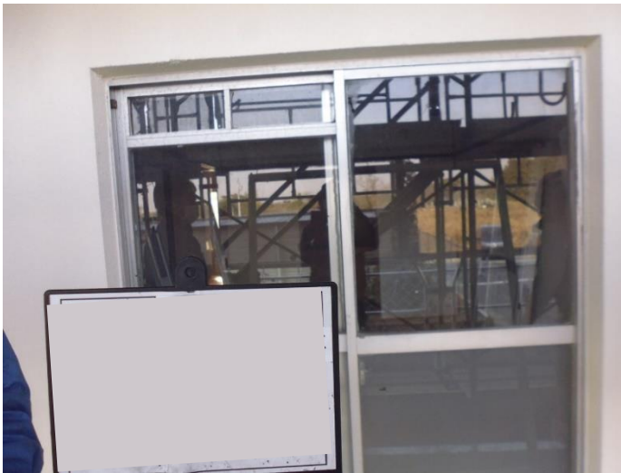
外部建具 改修 前
