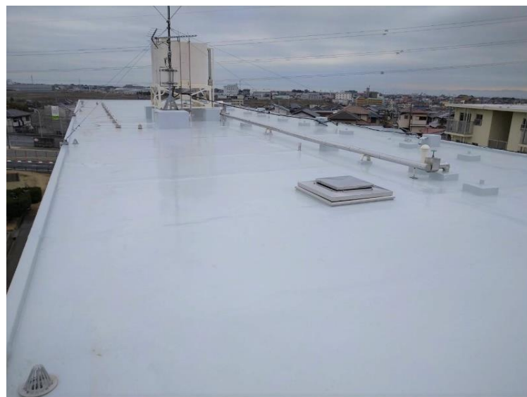
屋上防水 改修 後
