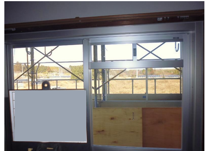
外部建具 改修 後
