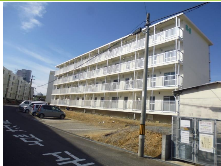
外壁塗装 改修 後
