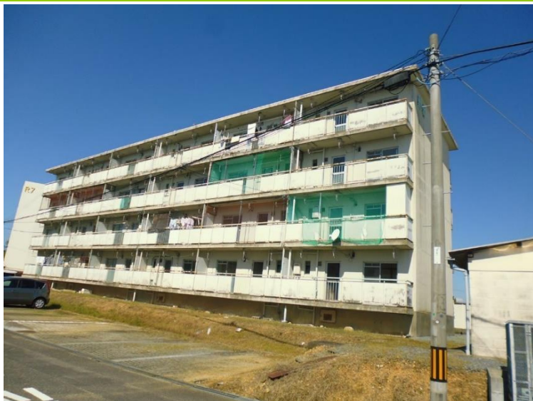
外壁塗装 改修 前
