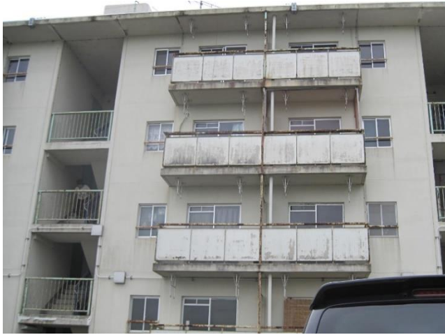
ベランダ手摺 改修 前
