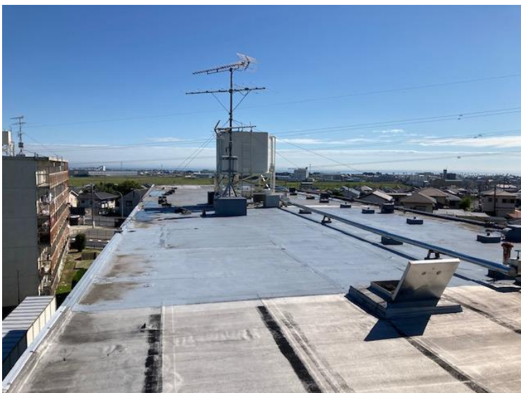
屋上防水 改修 前
