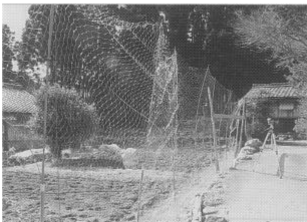
写真 - 1 . 試作した猿害防止柵
