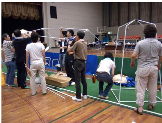
資機材組み立て
