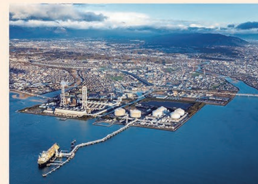
LNG(液化天然ガス)を使用した、世界最大級の川越火力発電所
