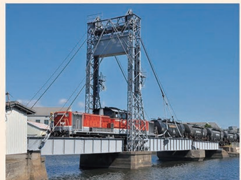
日本国内では現役唯一の跳開式可動鉄道橋梁である末広橋梁(四日市港)
