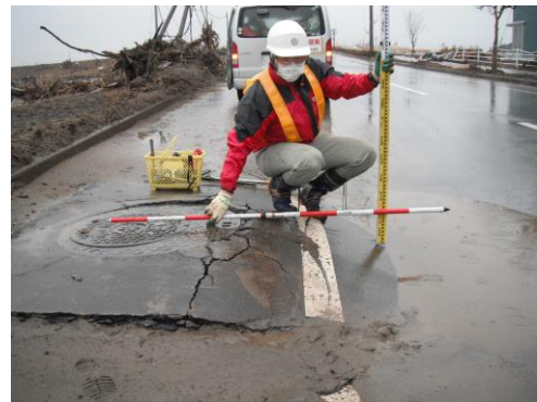
下水道管路被災調査
