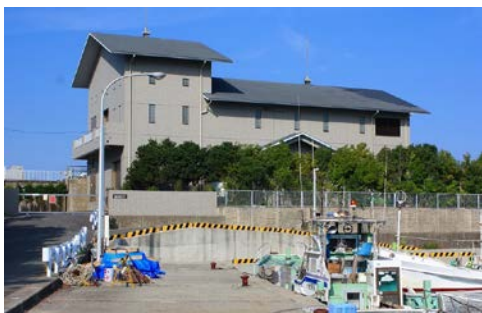
漁業集落排水処理施設
