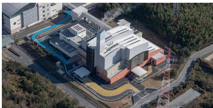
桑名広域清掃事業組合 可燃ごみ焼却施設
