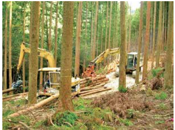
<高性能林業機械の連携作業>
