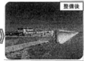
海岸堤防の耐震対策
