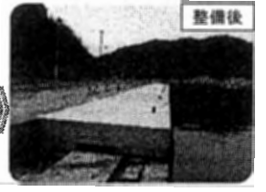
耐震岸壁の整備
