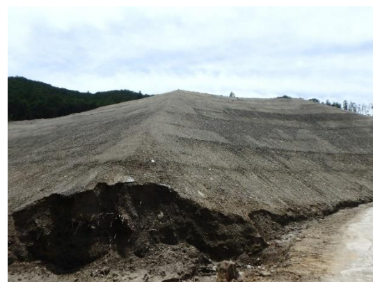
堆積状況（紀北町）
