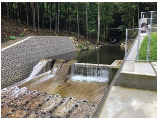
<馬野川小水力発電施設（取水口）>
