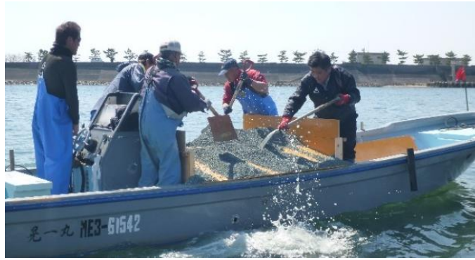
図9 スロープ船による施工
